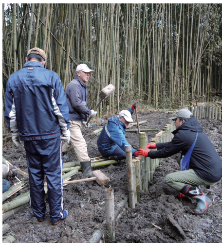
池の土留めの設置 伐採した竹を切り、池の土留めとして利用してる。
