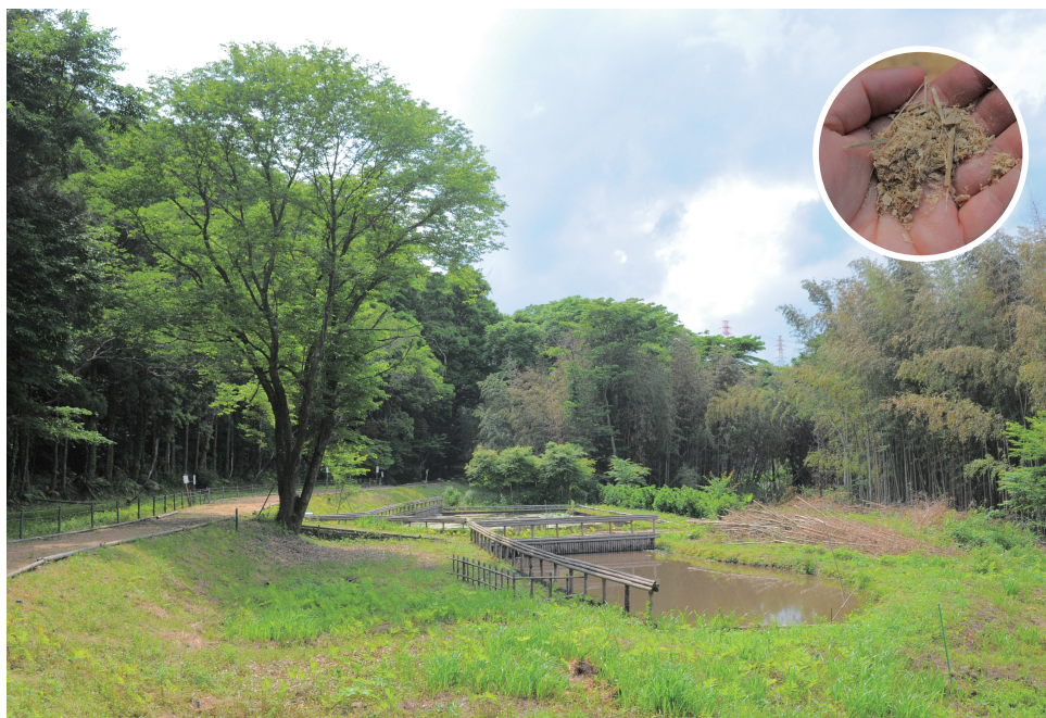
親水池付近 池の土留めには伐採した竹を利用している。また、遊歩道には竹を砕いたチップを敷き詰めてクッション性を高め、歩きやすくしている。右上が遊歩道に敷かれている竹チップ。
